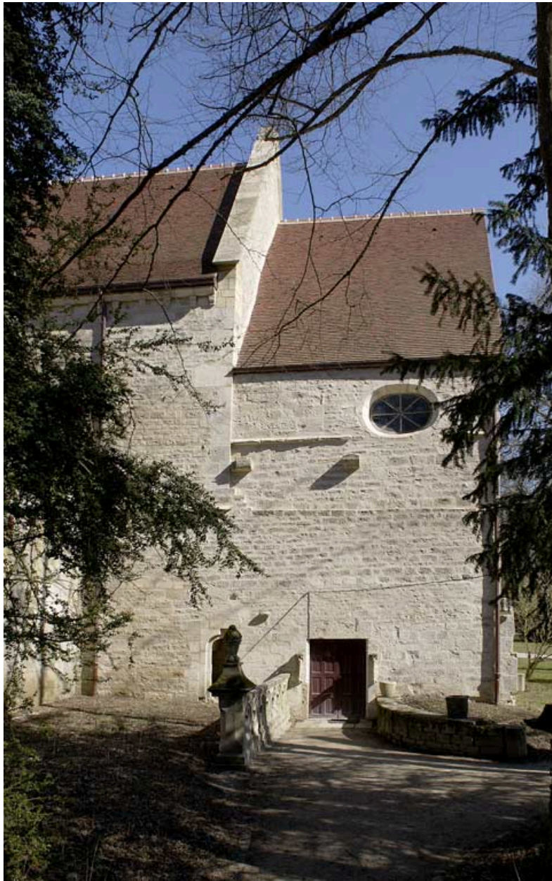
Extrémité nord de l'aile orientale : élévation ouest (côté cloître), porte d'entrée de la chapelle dite des fondateurs, anciennement sacristie et armarium.
