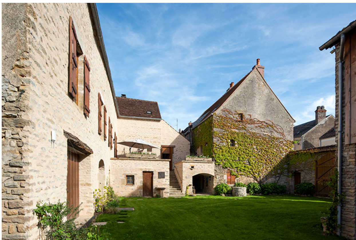
La cour, vue générale.
