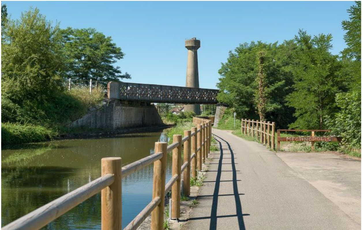
Le pont ferroviaire vu d'amont.
