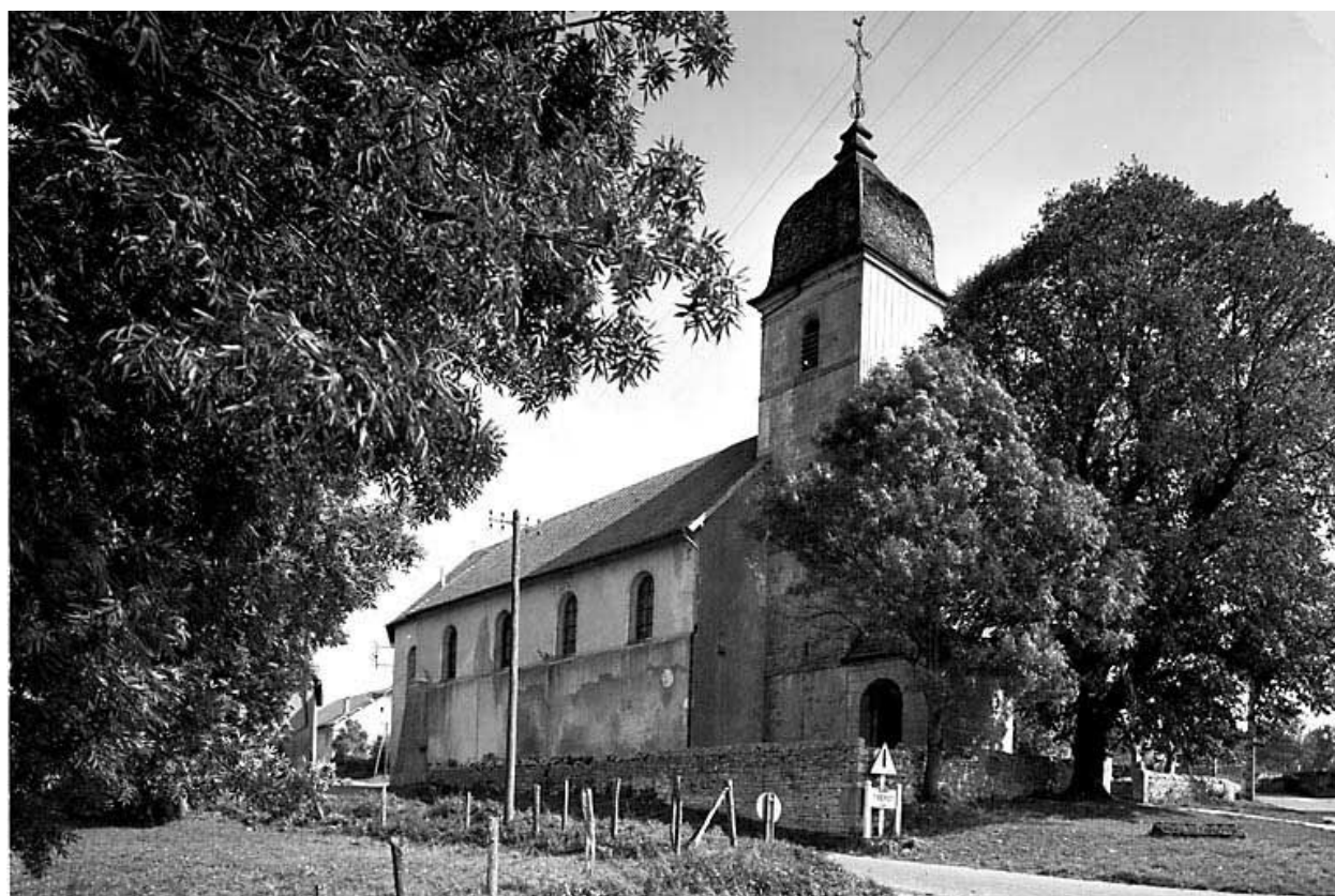
Eglise paroissiale Saint-Ferréol et Saint-Ferjeux.
