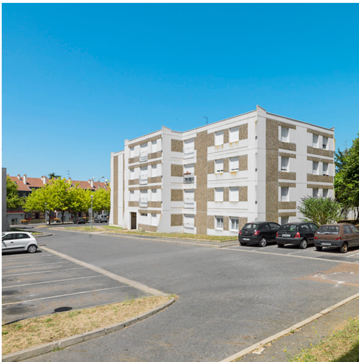
Bâtiment 26, façades antérieure et latérale.
