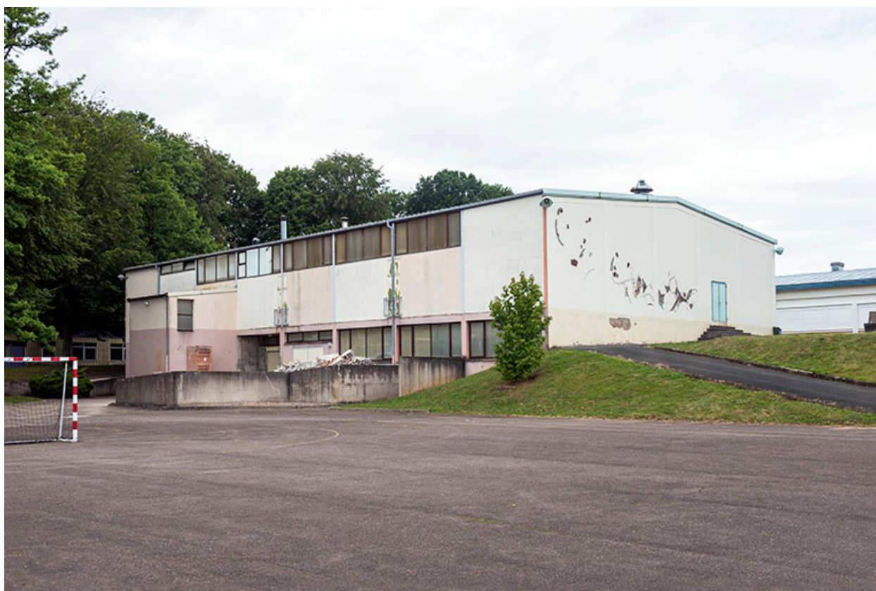
Atelier de gros oeuvre : vue trois-quart.
