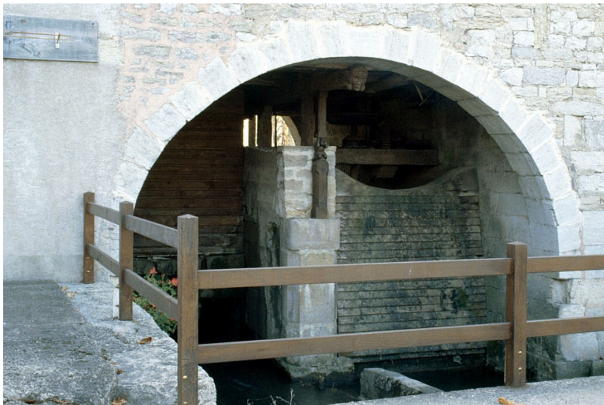
Chambre d'eau de la turbine, depuis l'aval.
