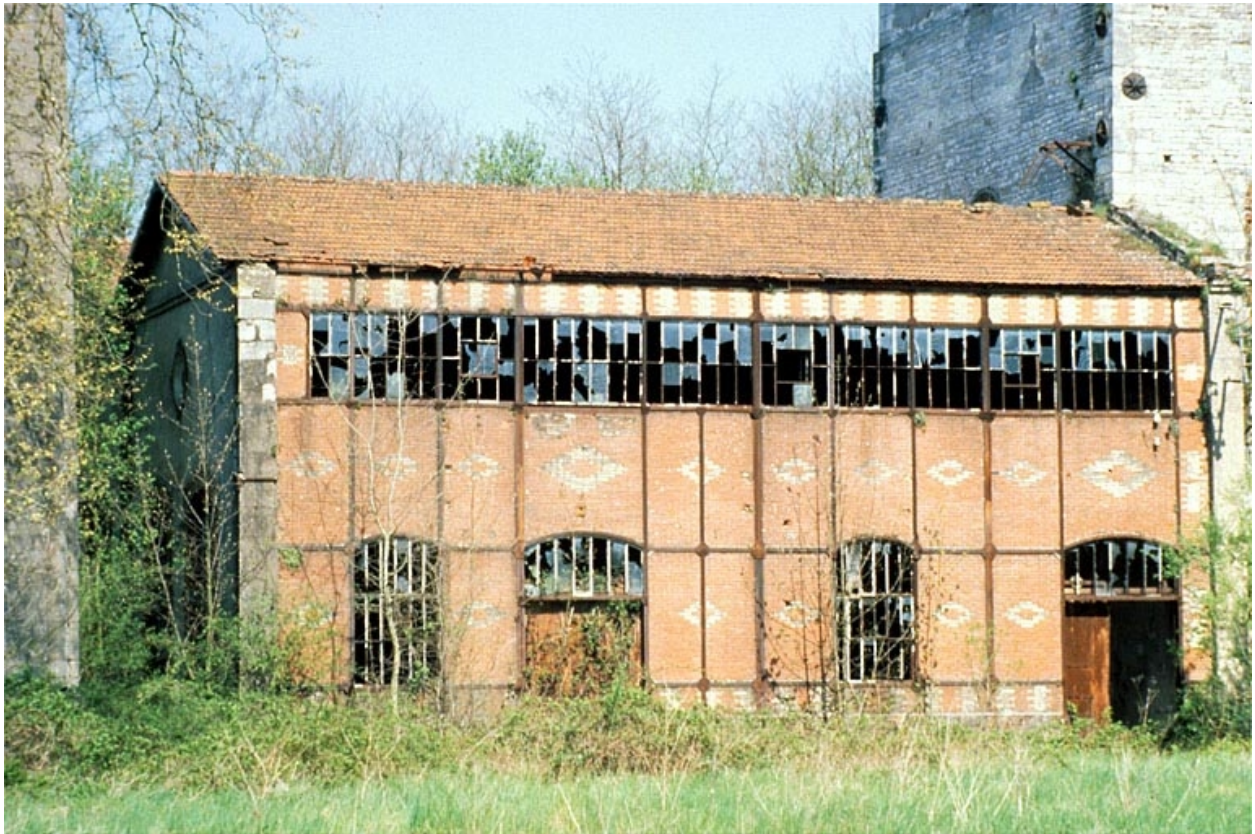
Forge Neuve. Centrale électrique : façade antérieure de la salle des machines (J).
