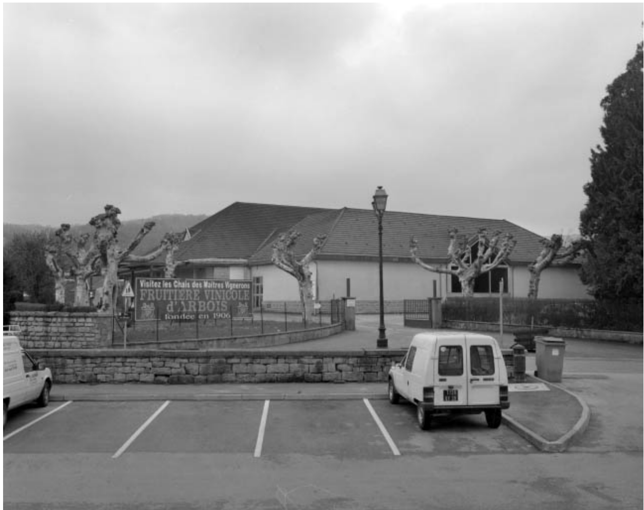
Vue d'ensemble de la nouvelle coopérative vinicole.
