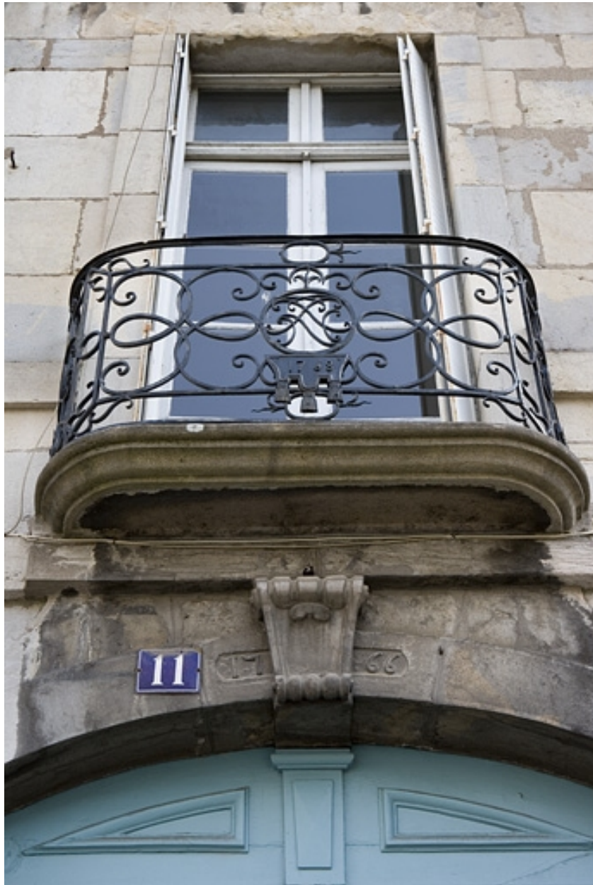
Détail du balcon en fer forgé sur rue avec la porte-fenêtre.
