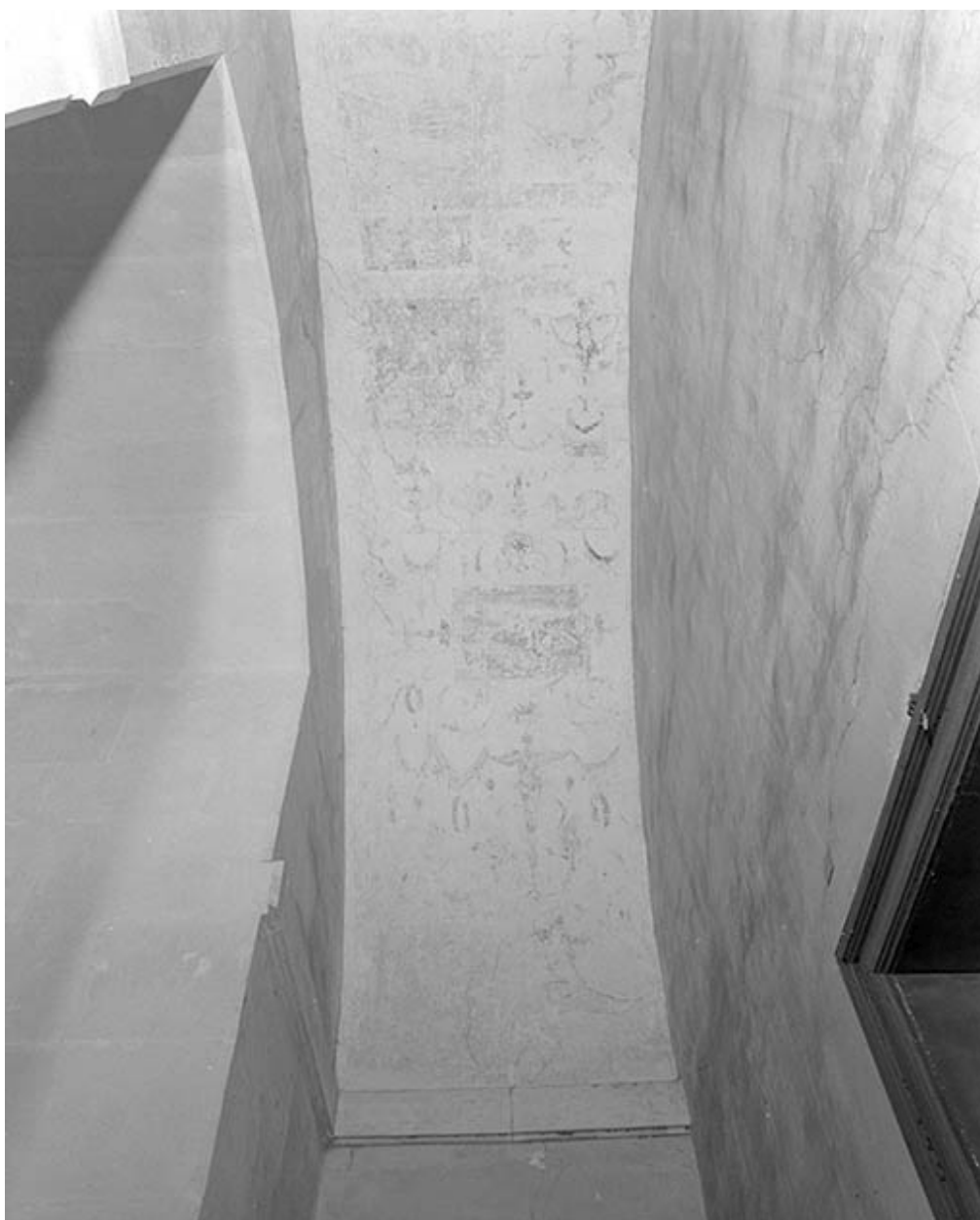
Chambre du Zodiaque, couloir, voûte, partie sud
