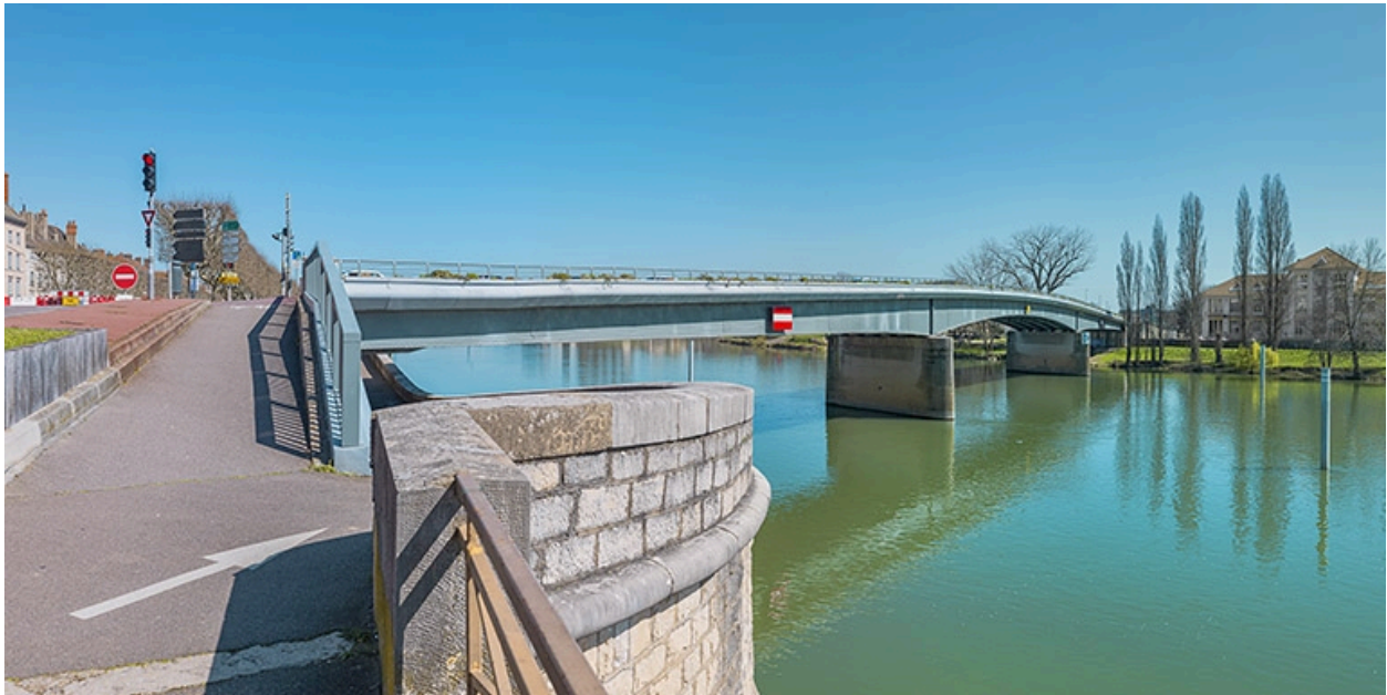
Vue d'ensemble du pont, prise d'aval. Au premier plan : la banquette de halage.
