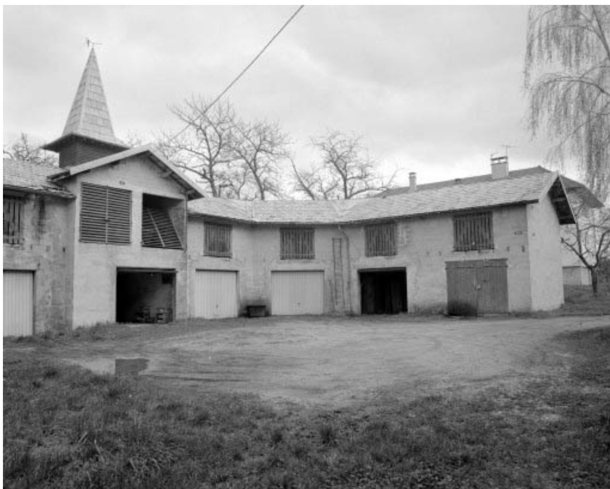
Remise d'automobile et bûcher (F) : cour.
