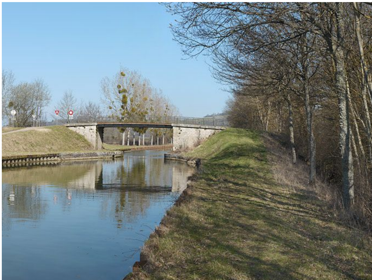
Le pont routier, vue d'ensemble.
