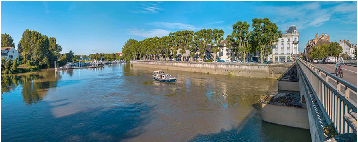
Vue des remparts depuis le pont, rue de Strasbourg.
