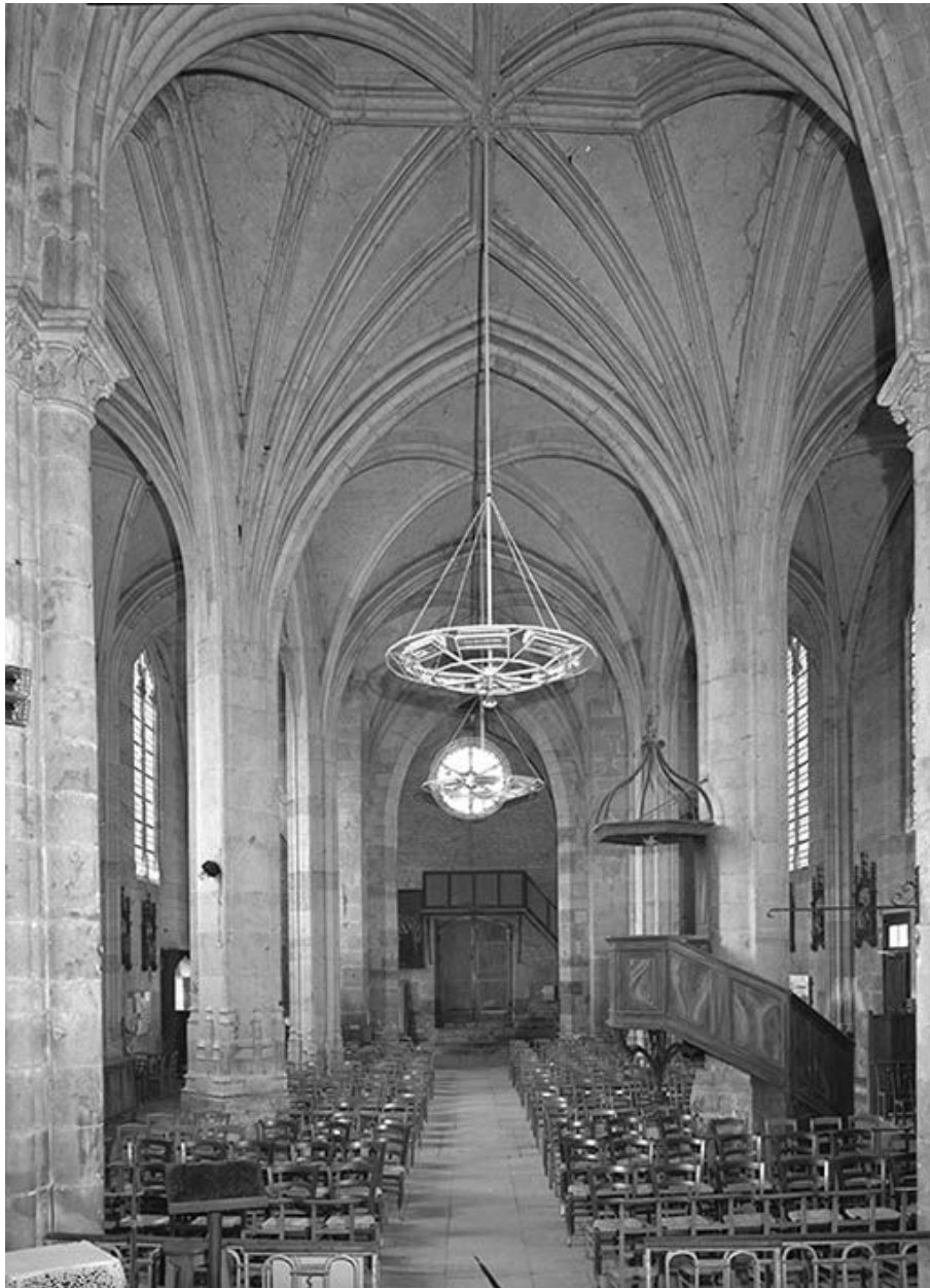
Vaisseau central, vue prise du choeur.
