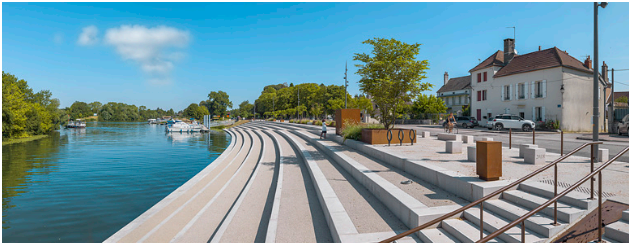
Vue d'ensemble des quais après leur réaménagement.
