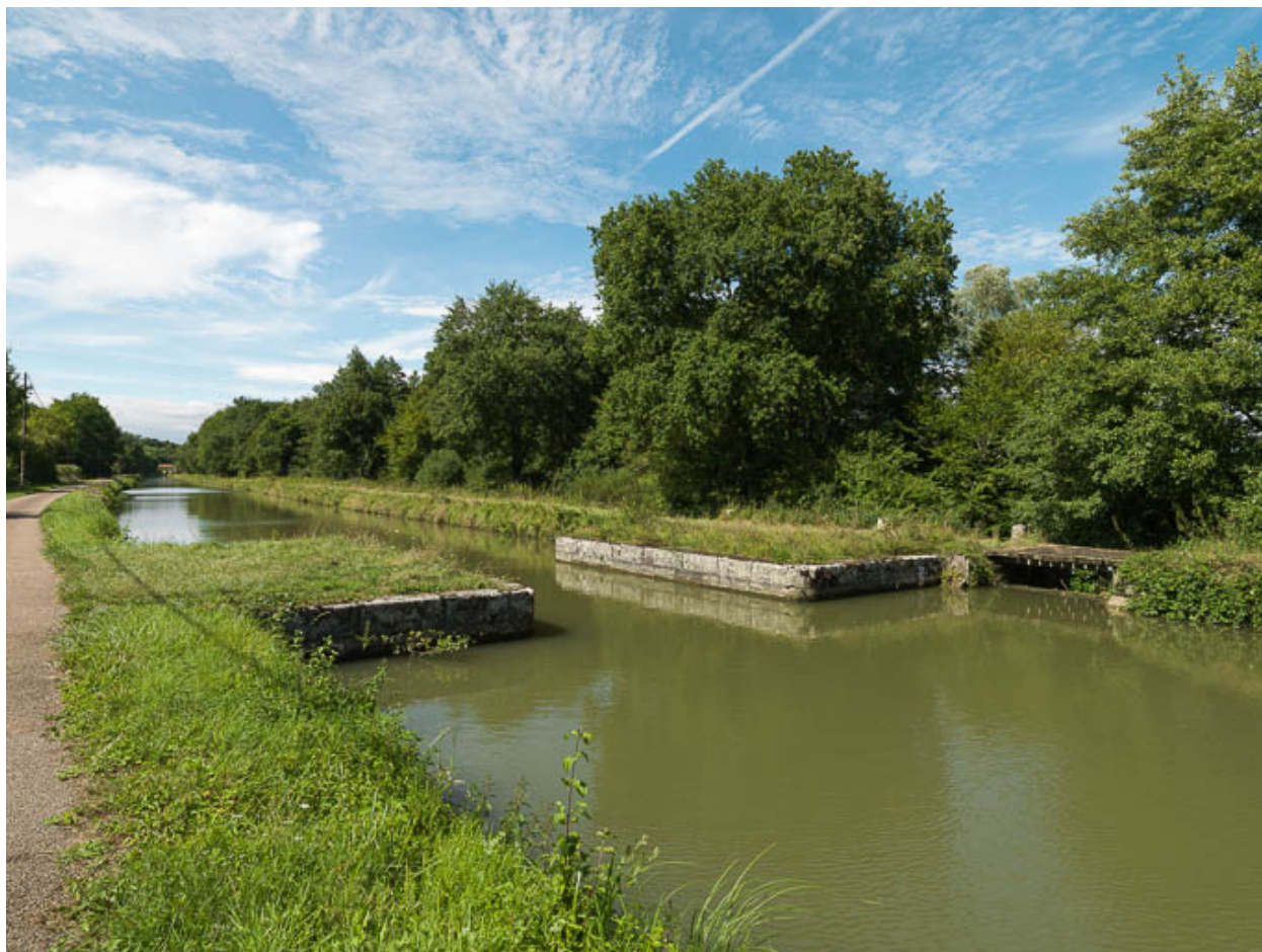
Vue du canal et du déversoir.
