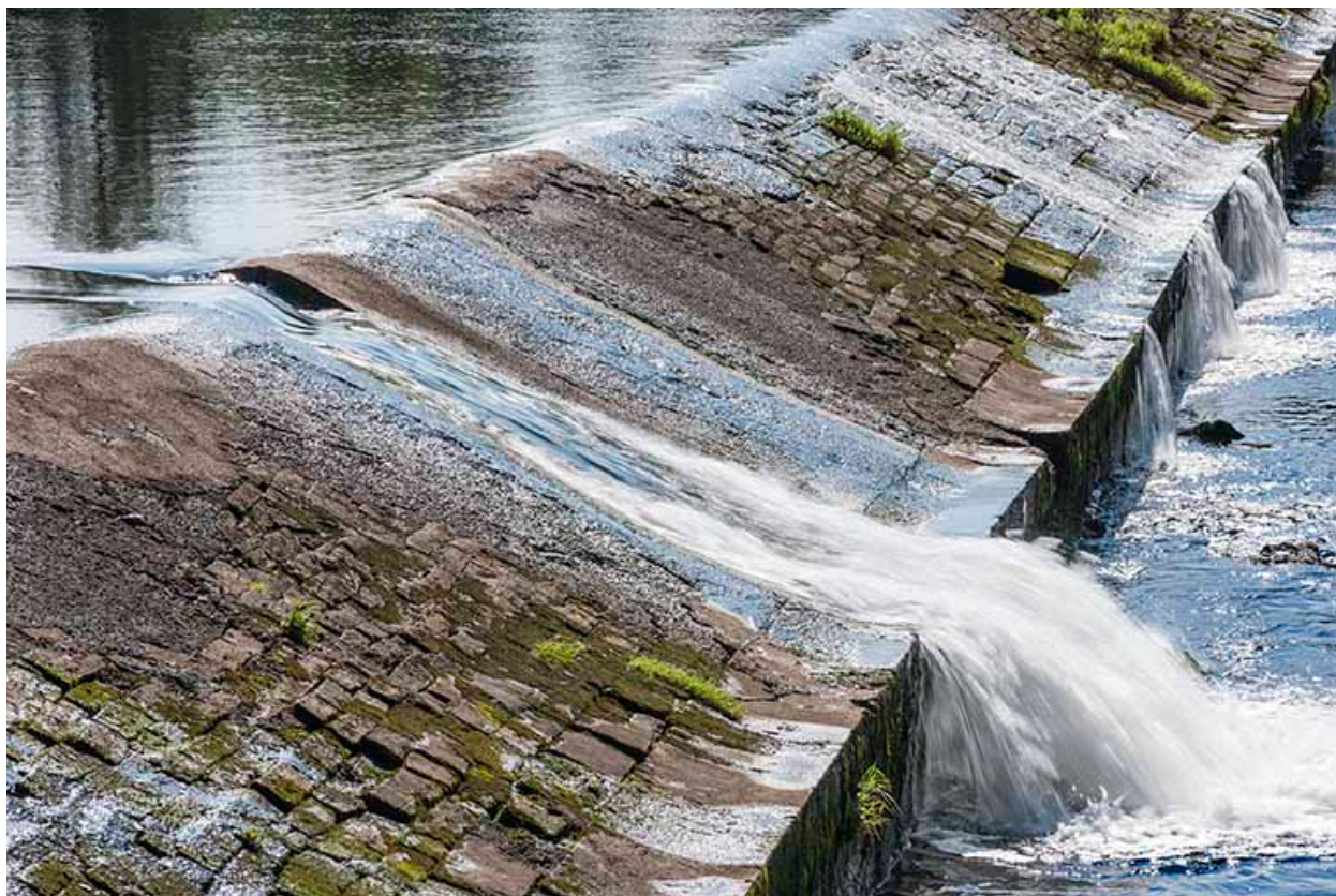
Vue de détail du barrage.
