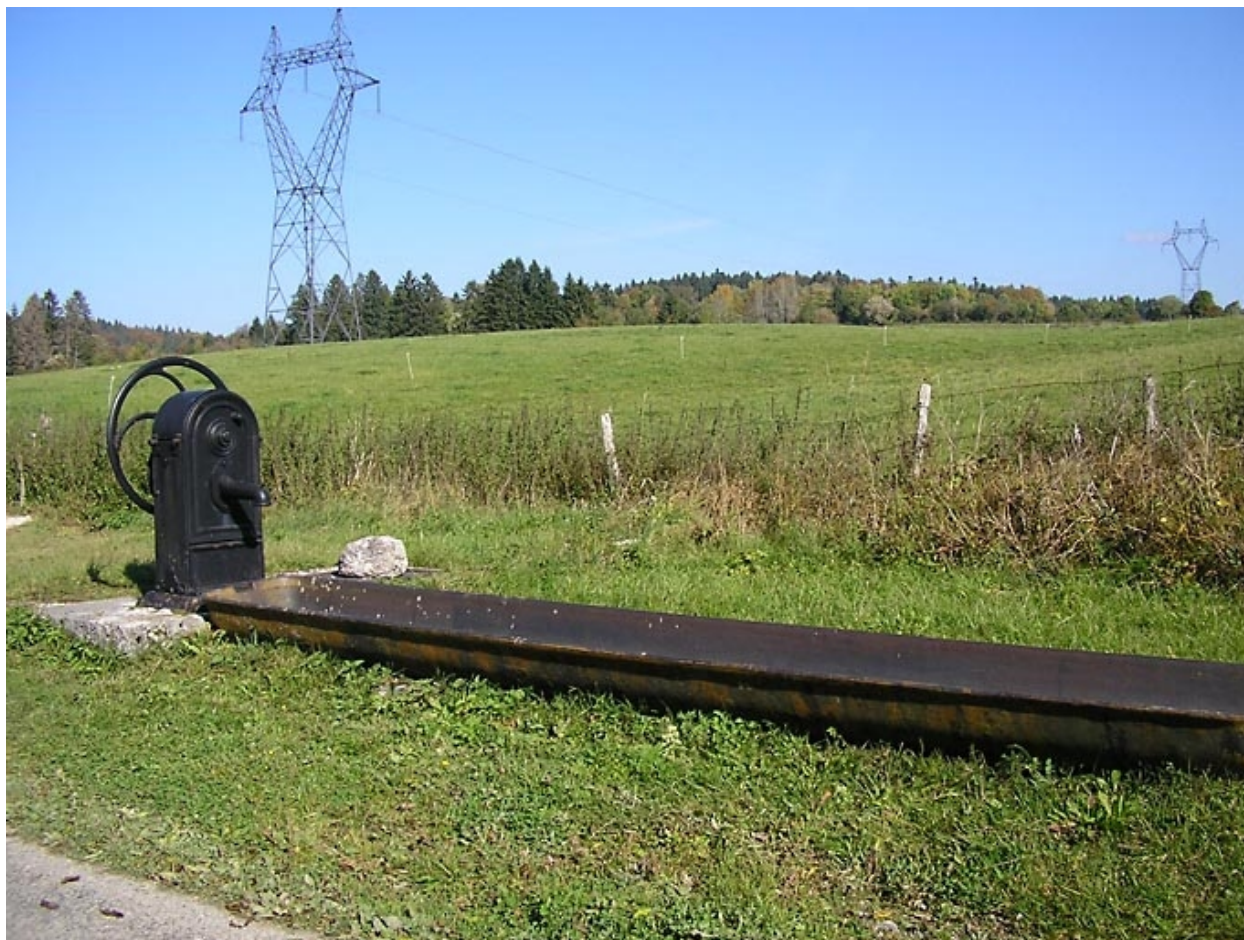
Fontaine-abreuvoir située au lieu-dit Les Croyets.
