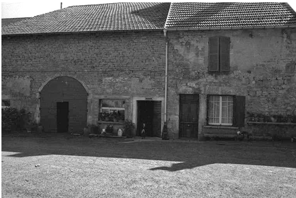
Fermes cadastrées 1957 A1 147, 148 et 151 : façades antérieures.
