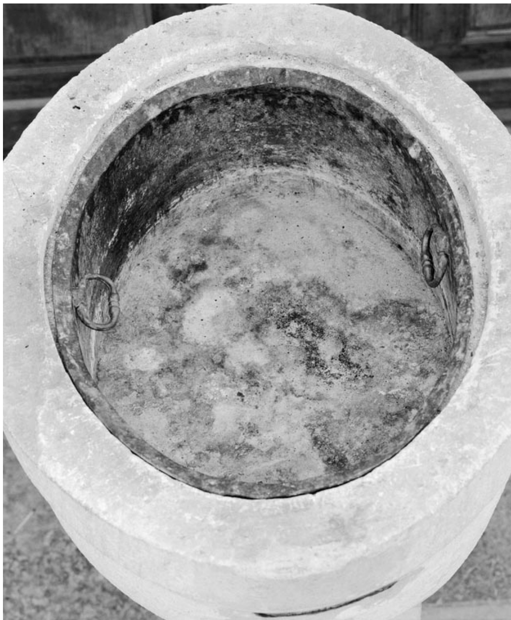
Détail de la cuve.
