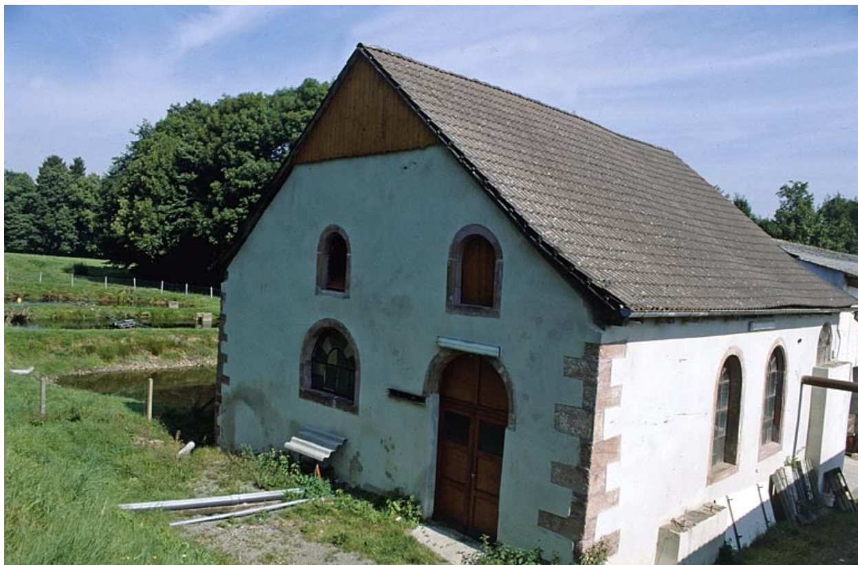
Salle des machines.
