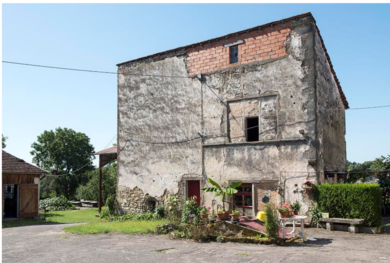
Ancien logis vu du nord-est.
