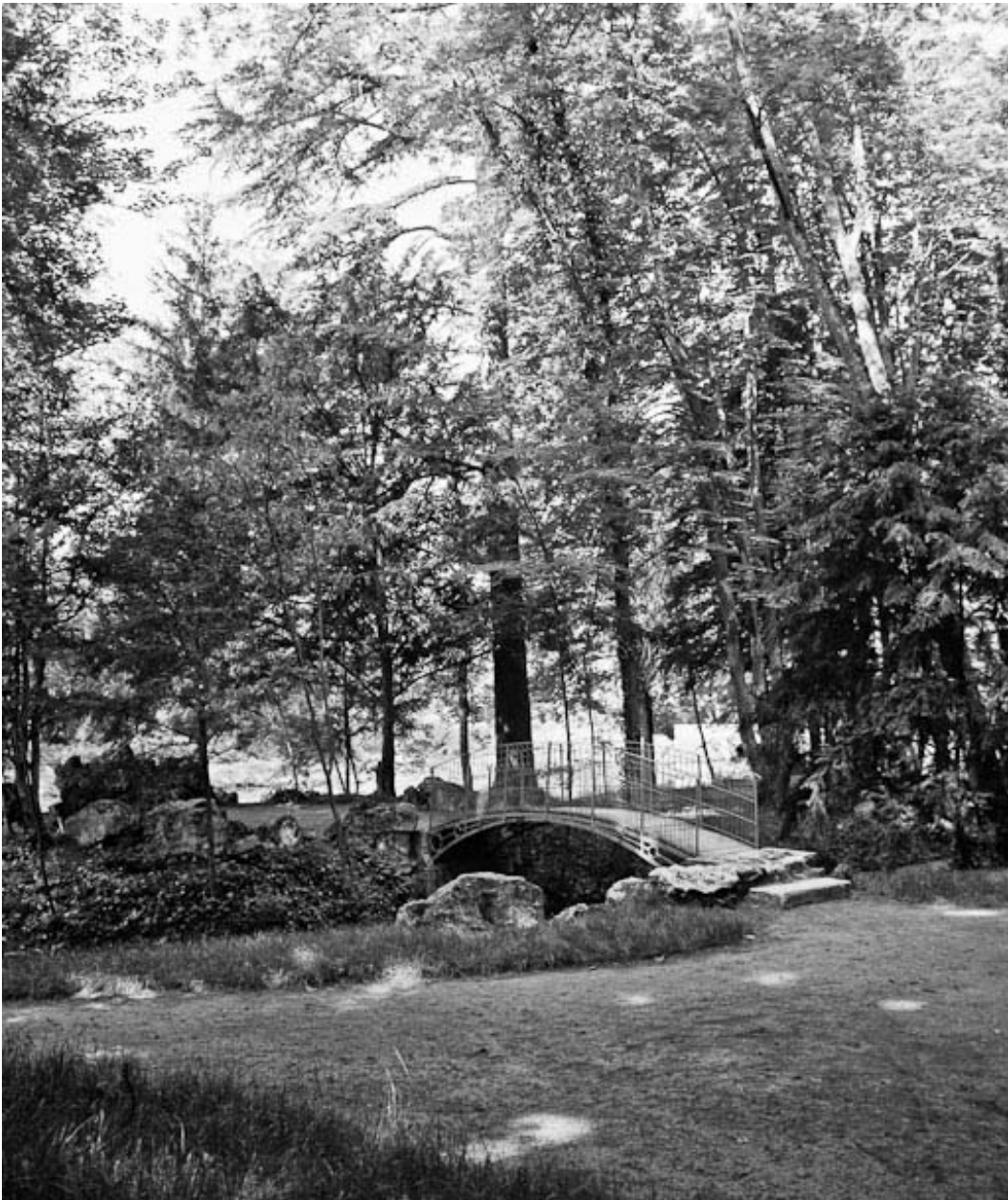
Passerelle métallique donnant accès à l'île (état en 1984).
