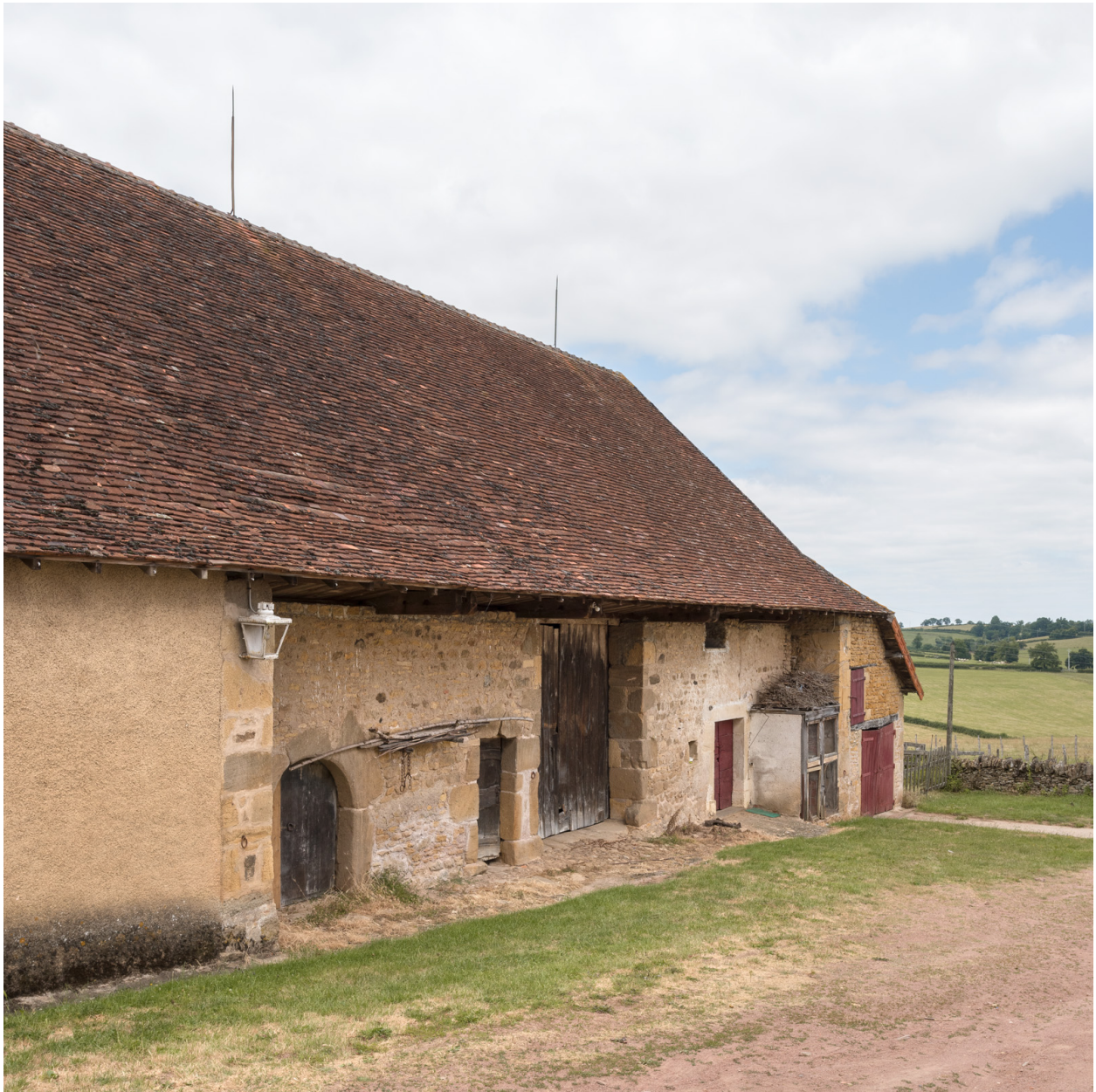
Façade antérieure du bâtiment agricole. Vue de trois quarts gauche.
