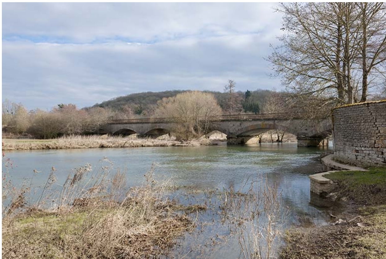
Pont ferroviaire sur la Lanterne (ligne Nancy-Gray).
