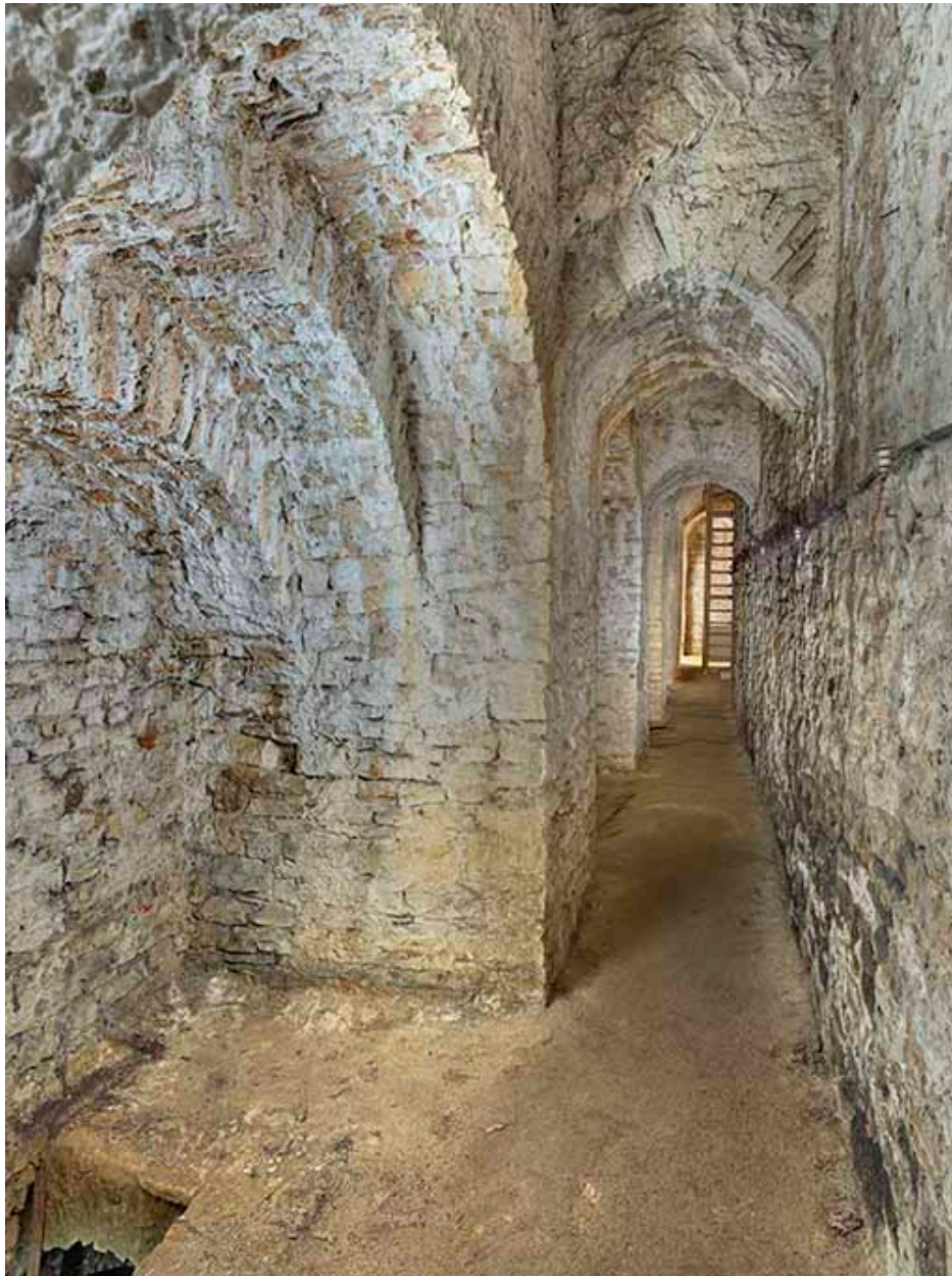
La galerie et sur la gauche, une casemate.
