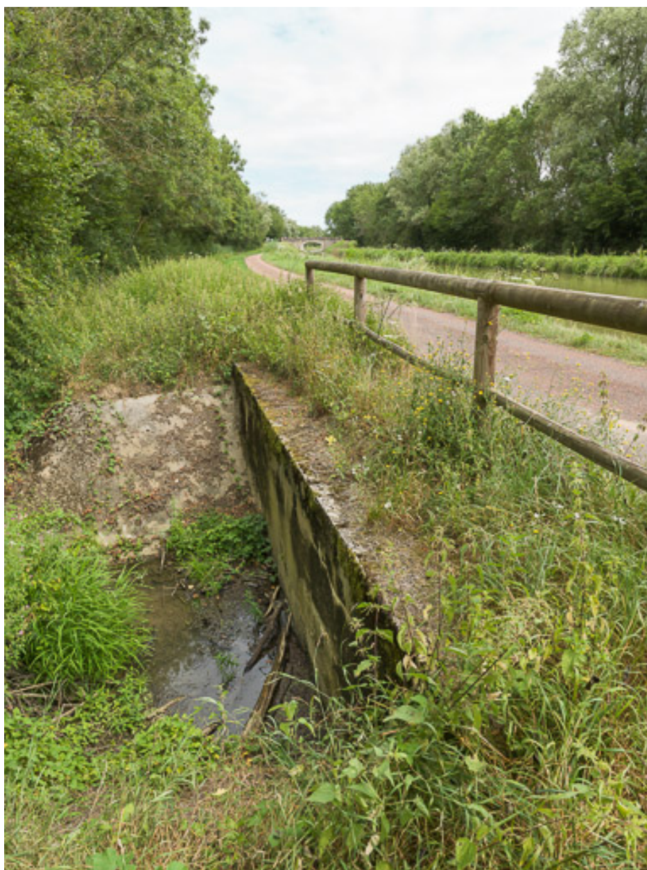
Vue de l'aqueduc.
