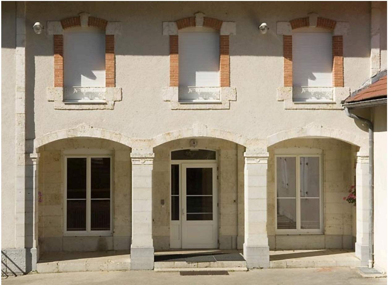
"Grand Château" : baies sur la façade antérieure.
