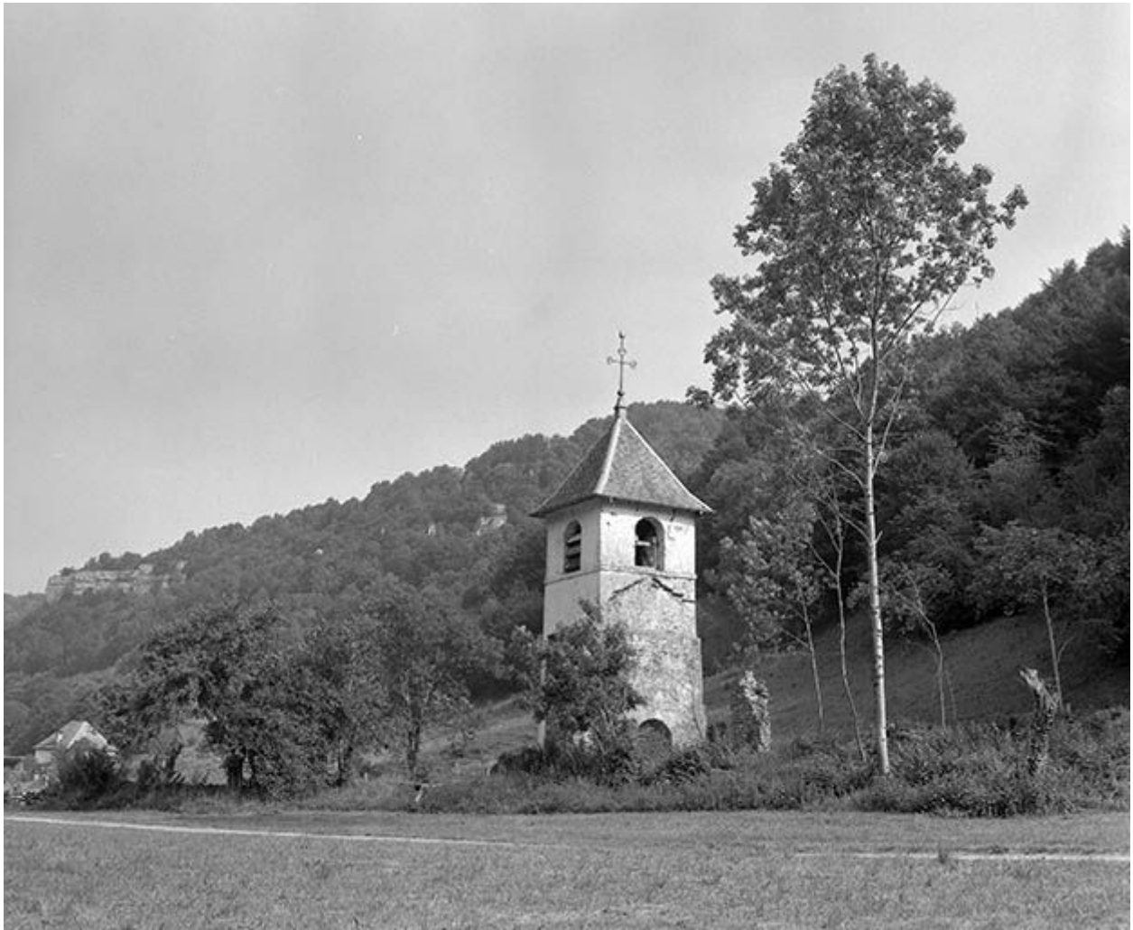
Tour du clocher depuis le sud-est.
