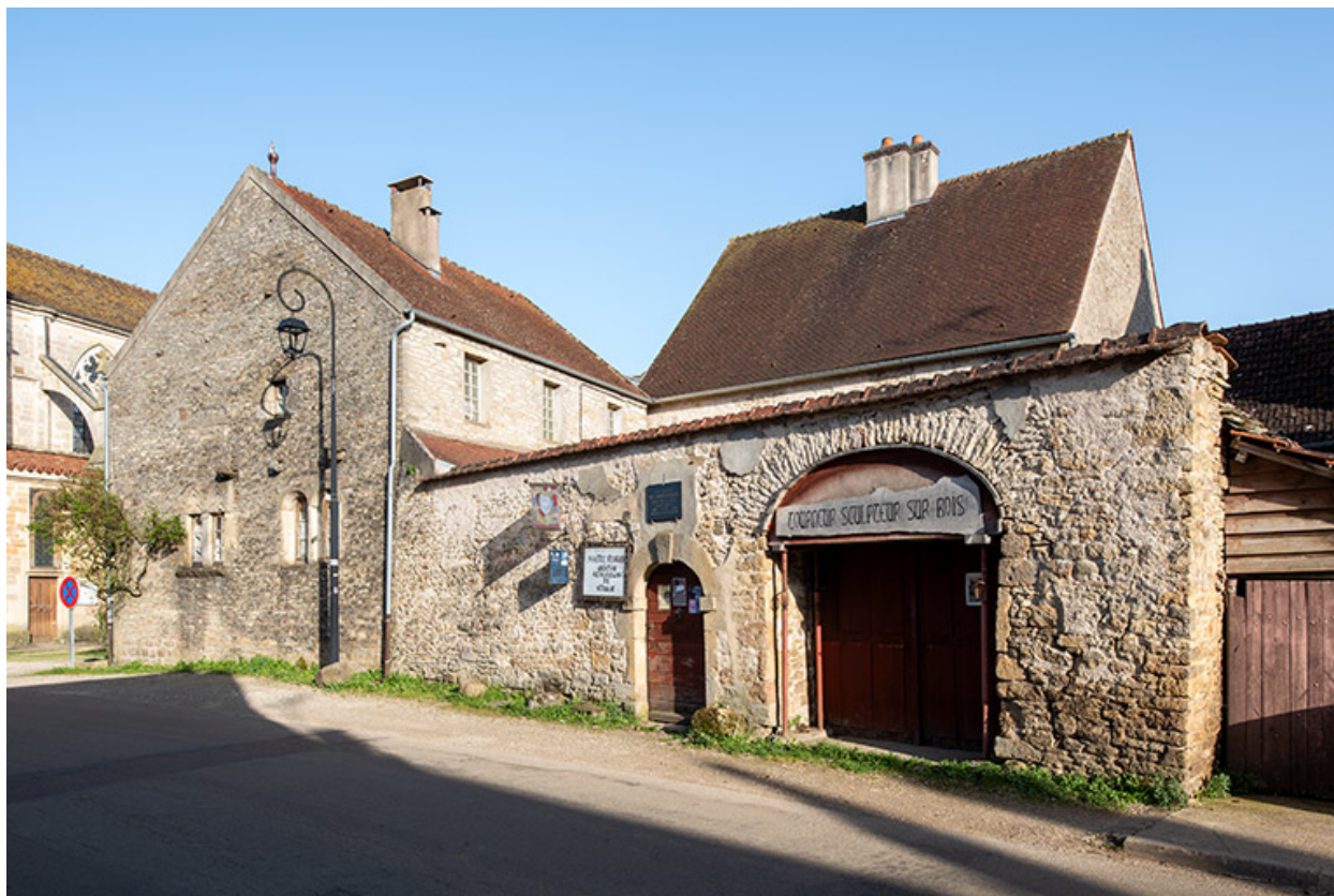
Le mur de clôture depuis la rue.
