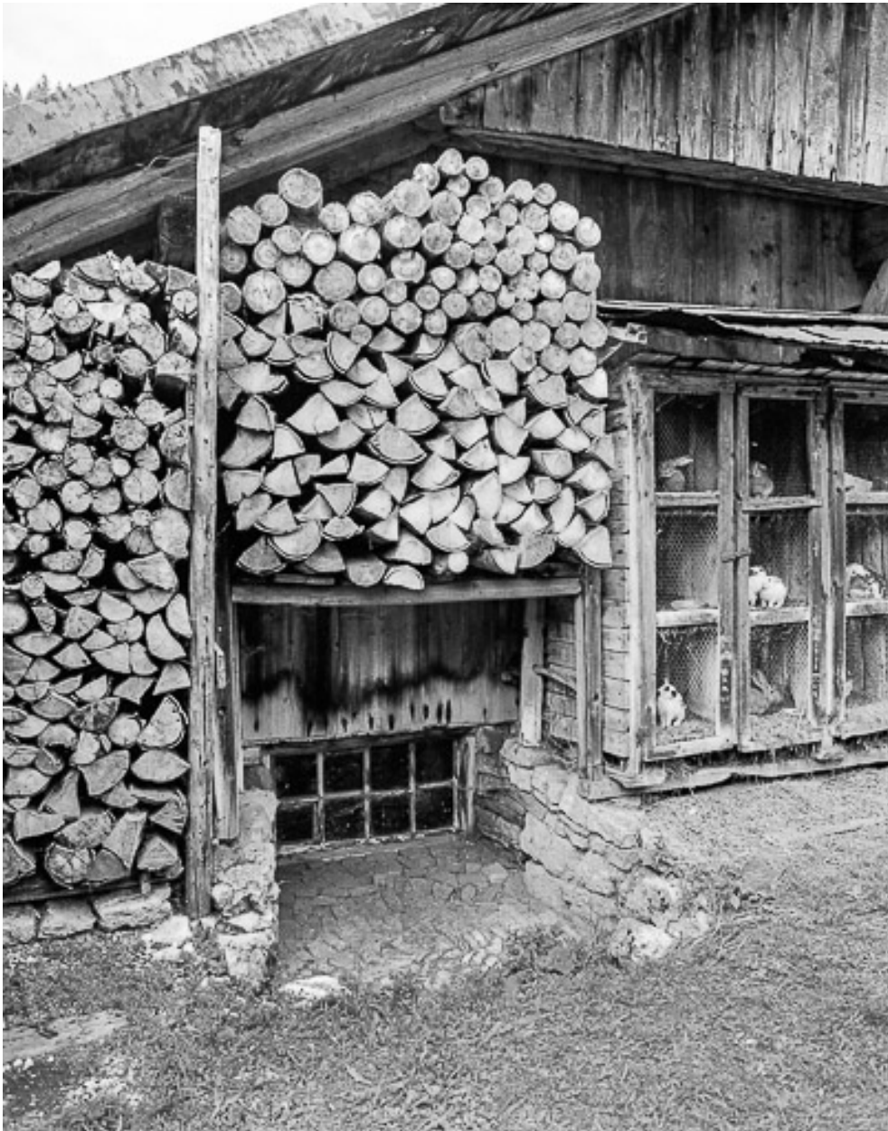
Détail : fenêtre de l'écurie.
