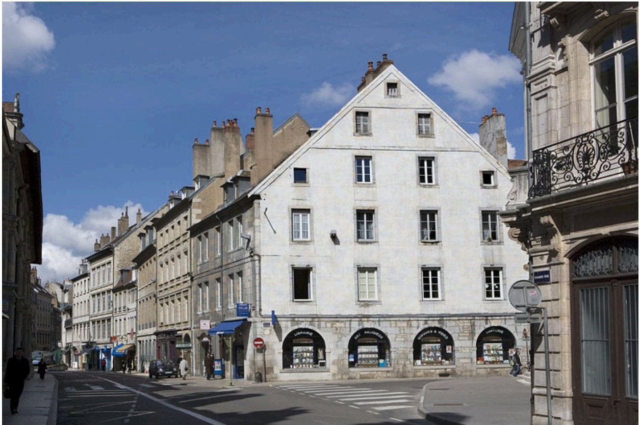
Vue d'ensemble du logis principal de trois quarts droit.
