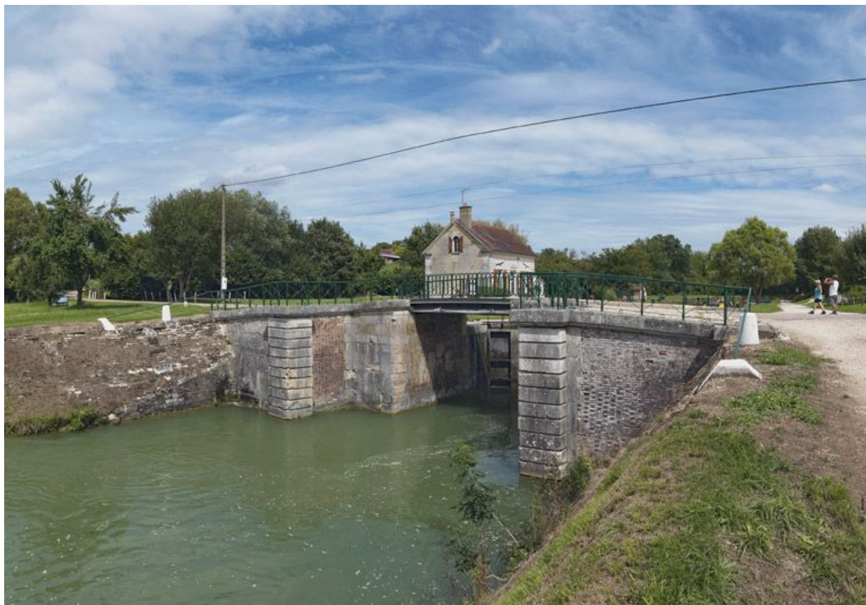
Vue d'ensemble, prise d'aval.
