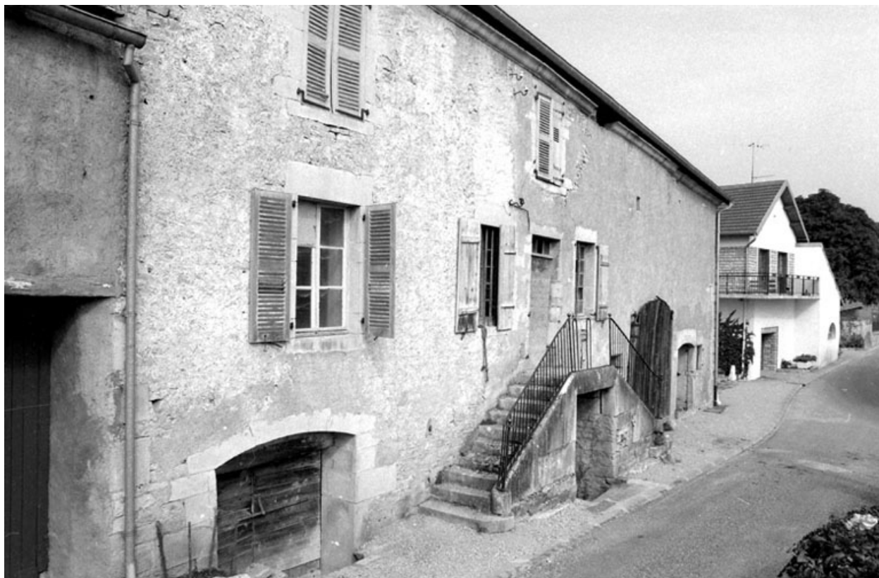
Hugier : ferme située rue de Pampouille.
