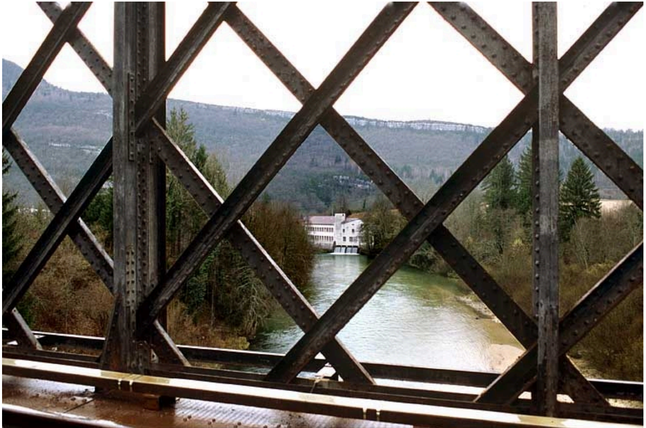
Paroi aval, depuis le tablier côté Andelot-en-Montagne : détail.
