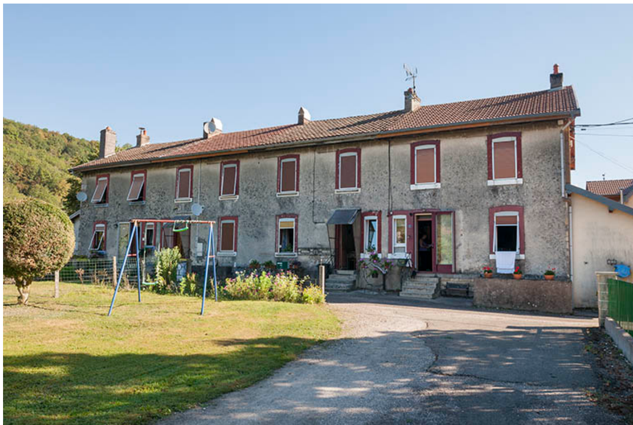
Logement ouvrier (8 appartements). Vue depuis le nord.
