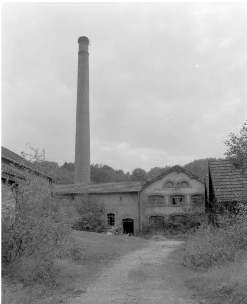
Façade nord de l'atelier de galvanisation en 1981.
