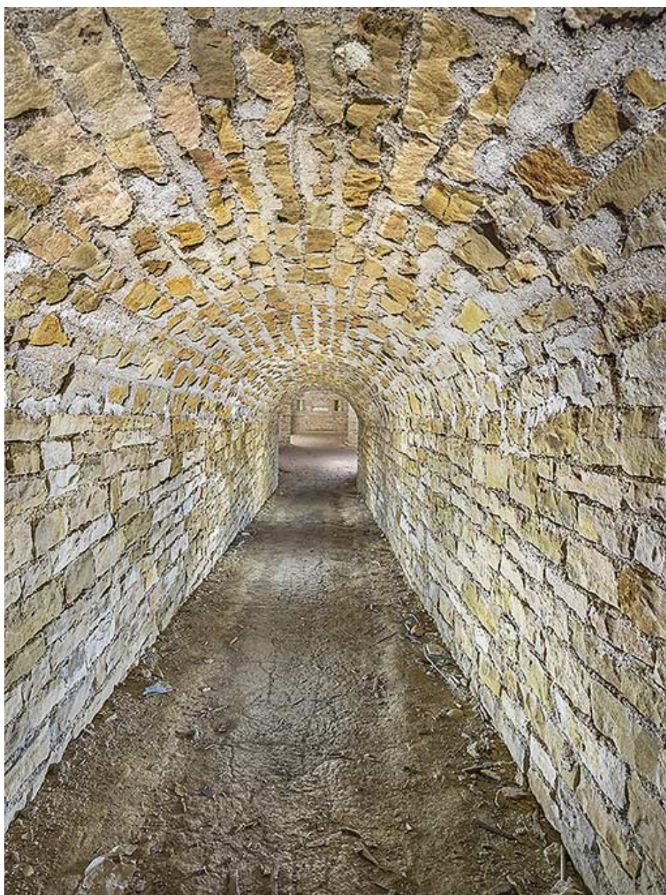
Couloir d'accès de la double caponnière.
