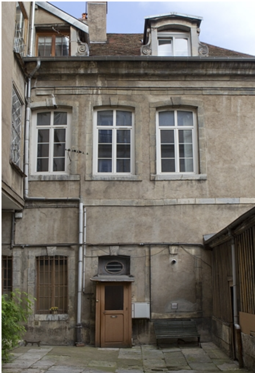
Vue d'ensemble de l'aile droite sur cour.
