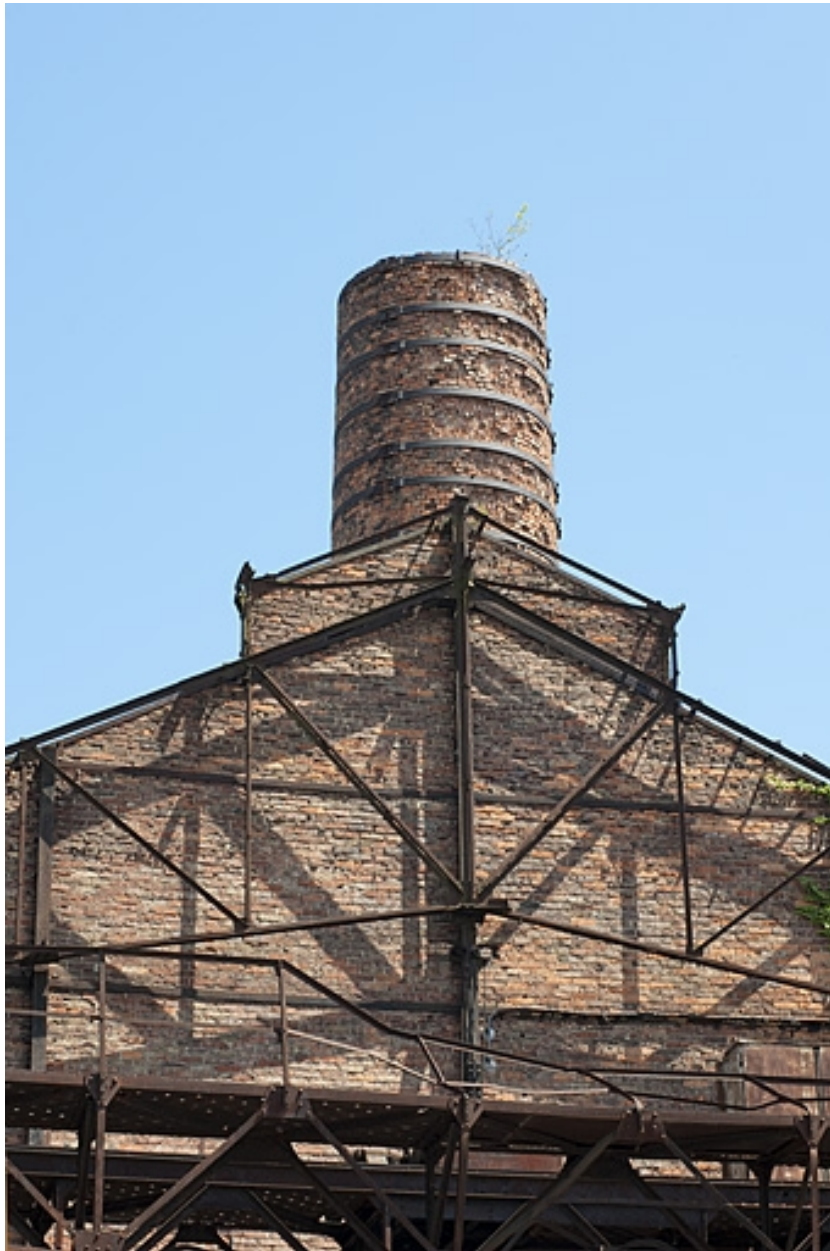
Atelier de laminage découvert. Détail du pignon est.
