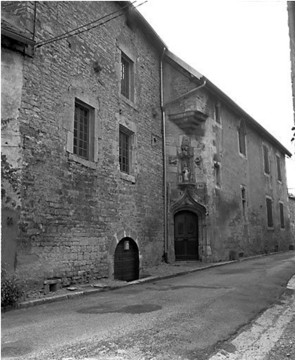
Maison de Balthazar Gérard située 3 rue Gérard.
