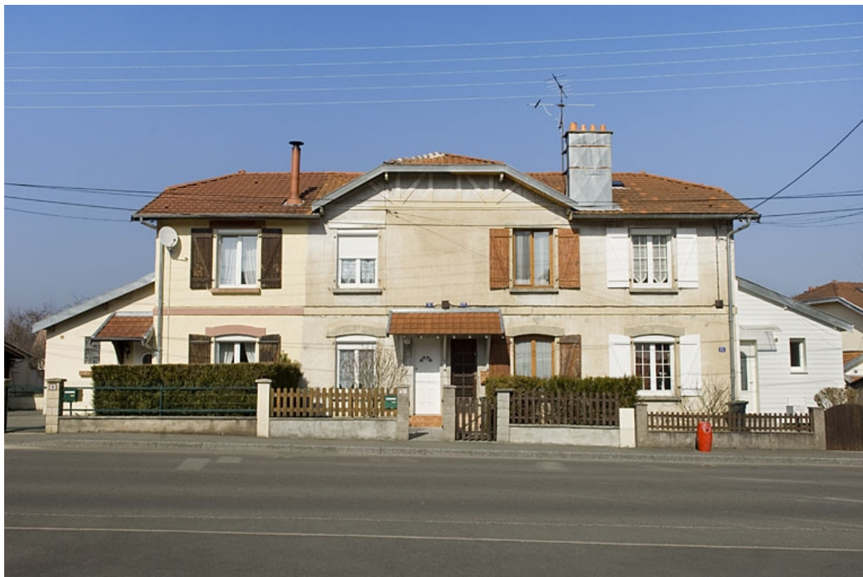
Habitation à 4 logements. Vue de face.
