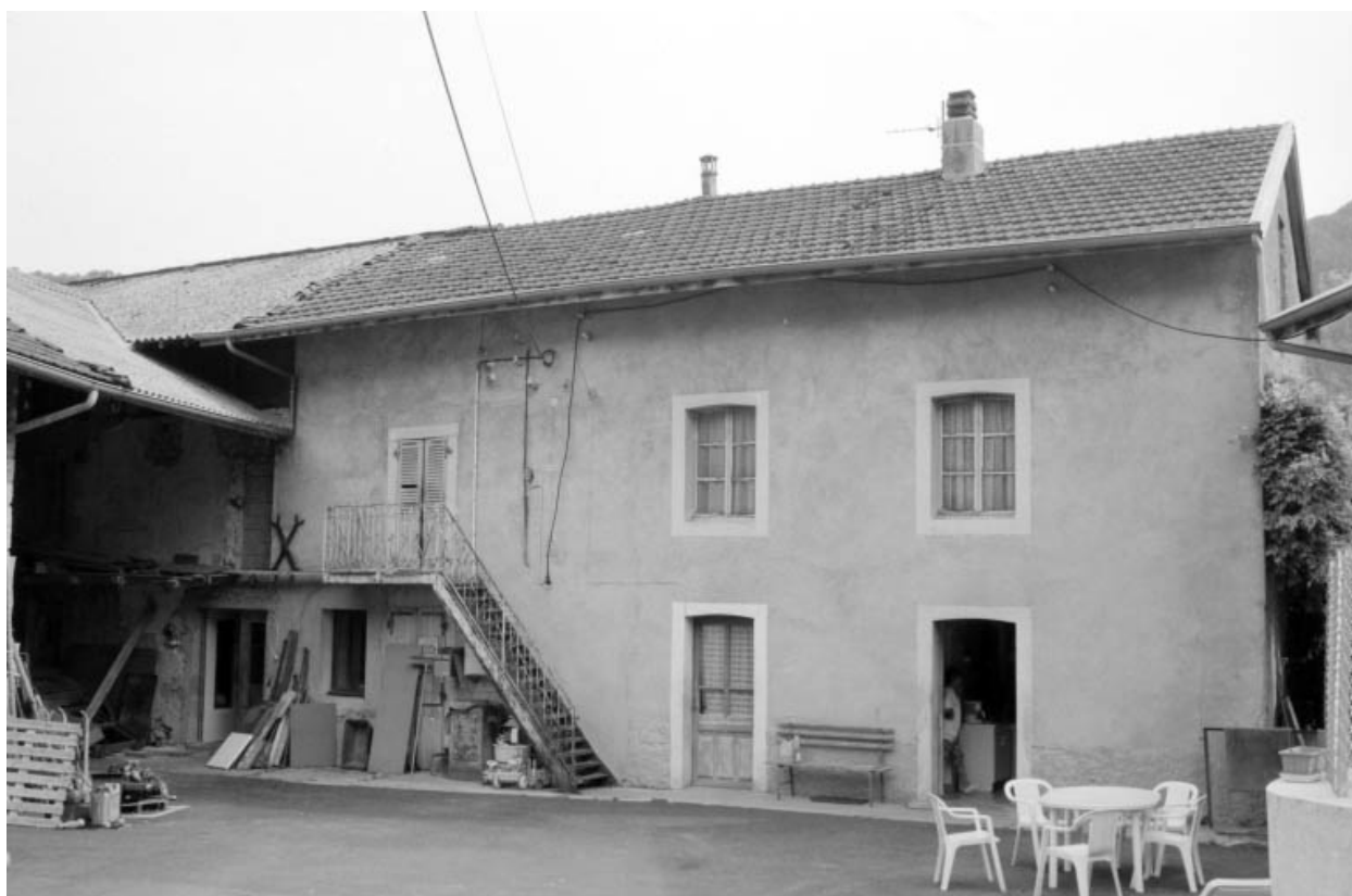
Façade antérieure du logement.
