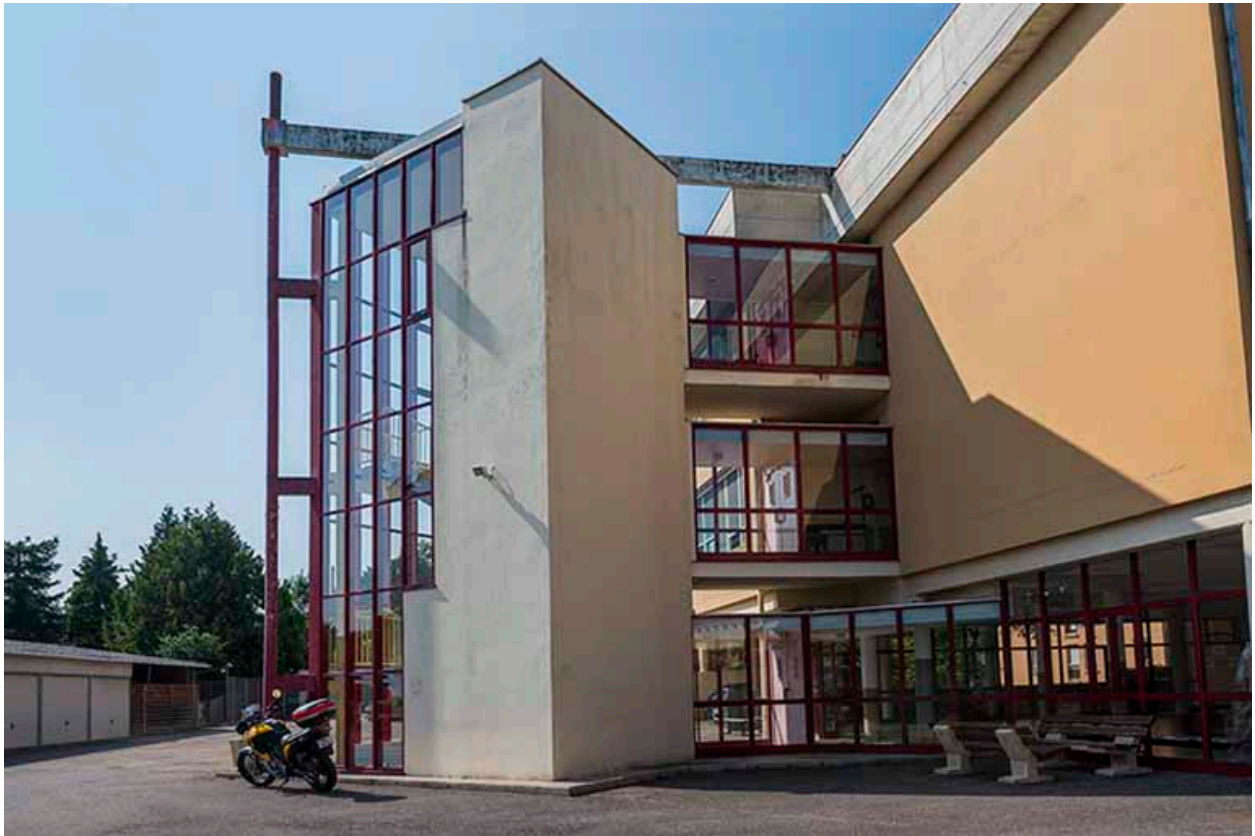
Détail de l'escalier dit le phare.
