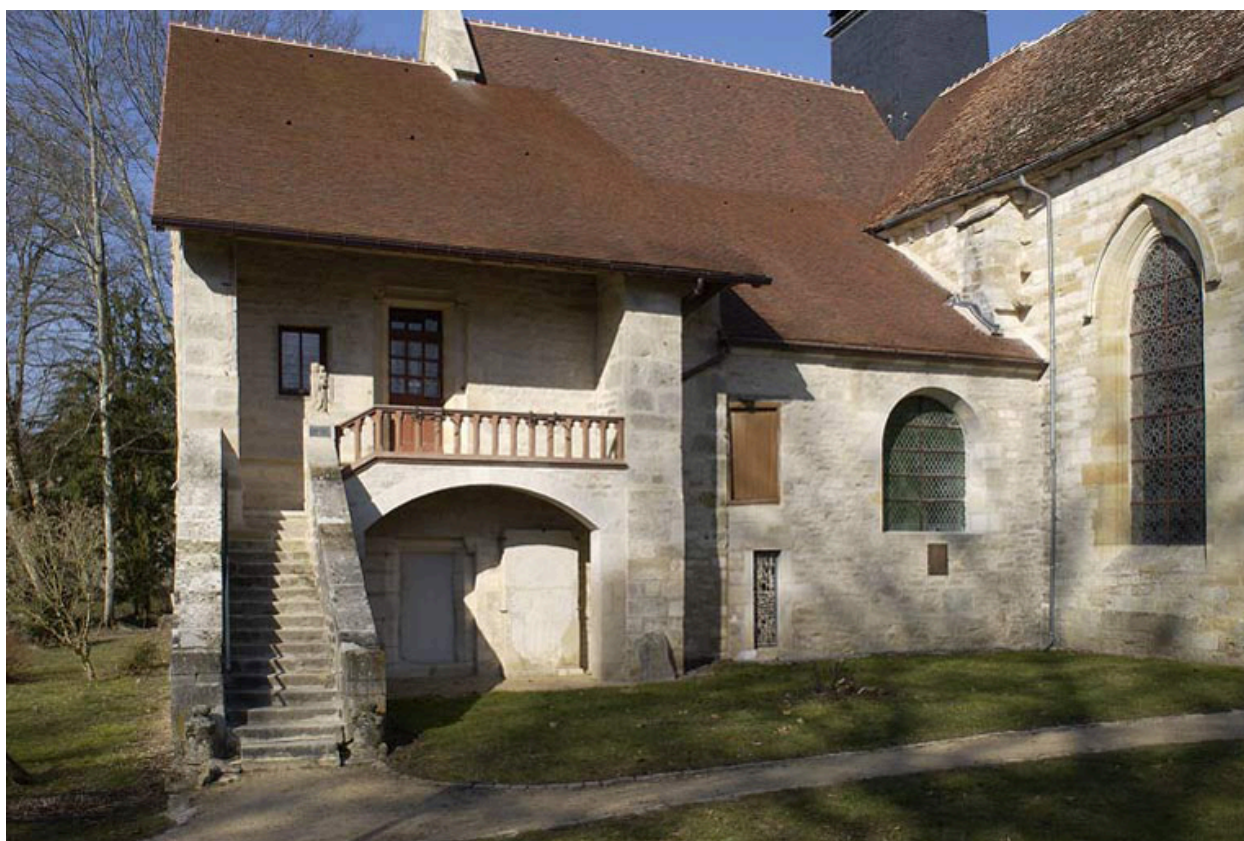
Extrémité nord de l'aile orientale : élévation est.
