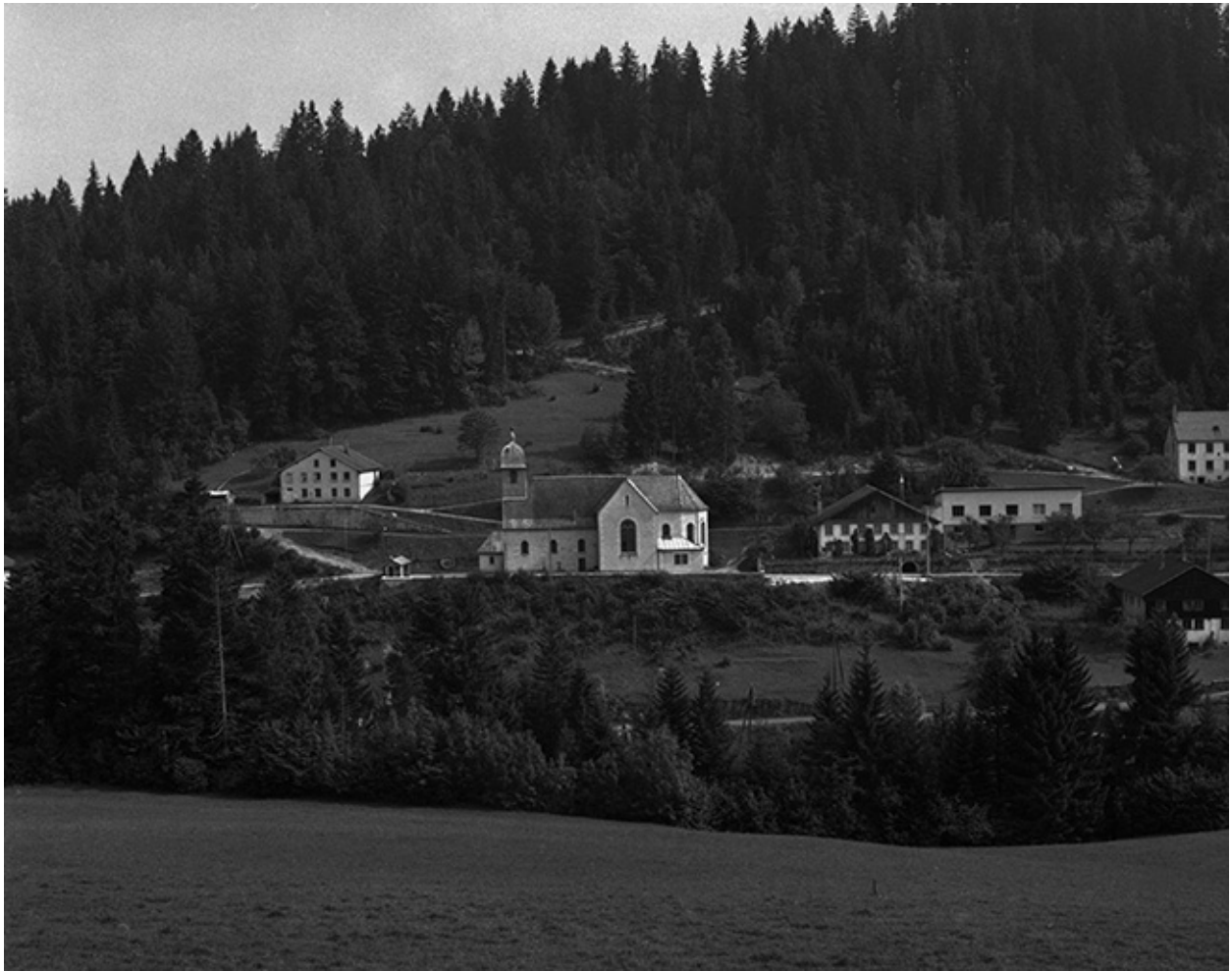
Façade latérale droite.
