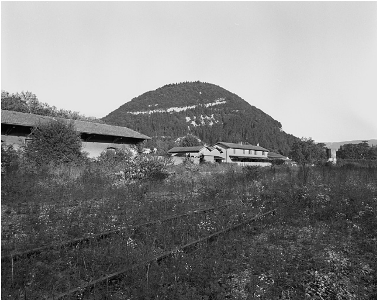
Vue d'ensemble de l'entrepôt et du site, depuis l'ouest.
