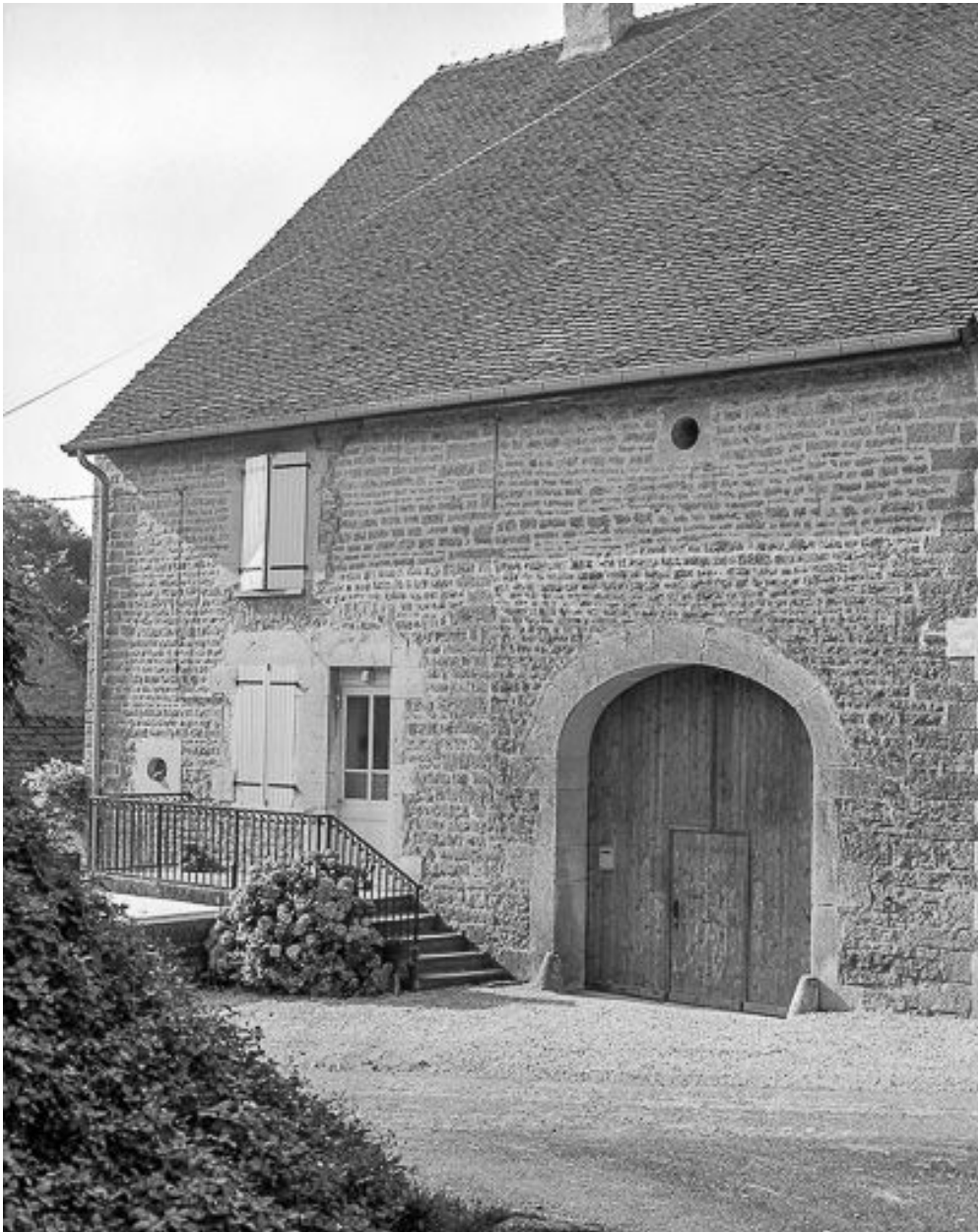
Ferme située rue du Bas du Village.
